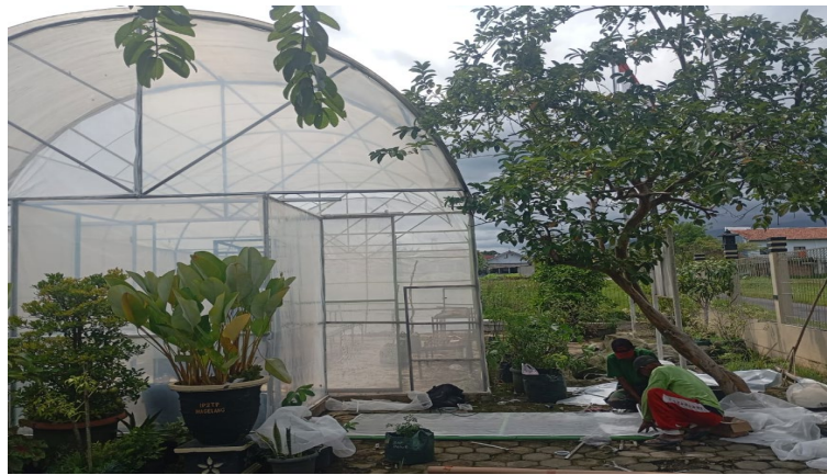
Gambar 33. Perbaikan Screen House IP2MP Magelang
