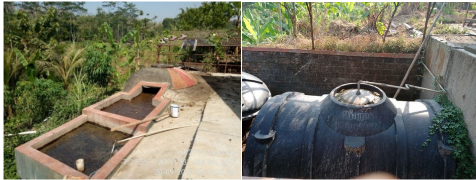
Gambar 30. Instalasi Biogas di IP2MP Magelang
